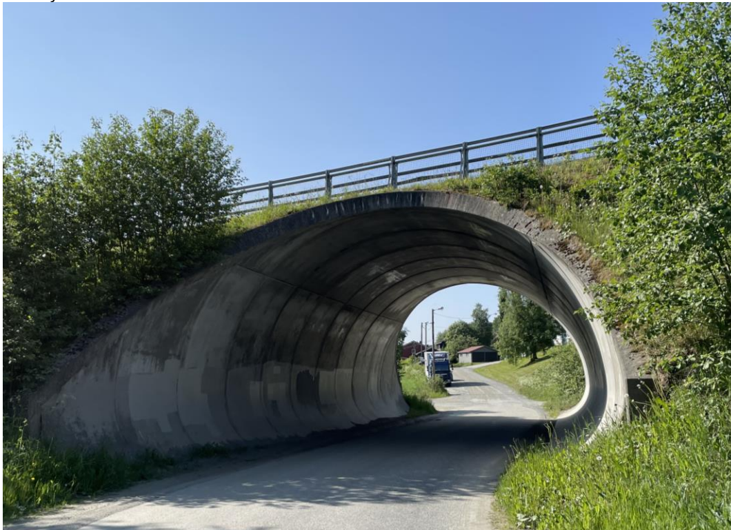
Figur 4.6 Kulvert i Bagøyvegen sett fra nord. (Bilde: NIRAS)
