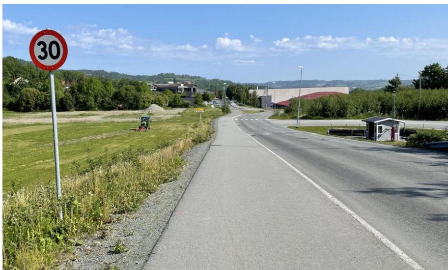
Figur 4.3 Martin Tranmælsveg sett nordover fra kryss Hølundvegen. Monstuflate på venstre side av bildet (Bilde: NIRAS).
