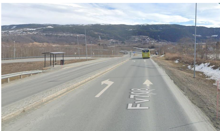
Figur 4.4 Hølundvegen sett fra vest, med bussholdeplass i vestlig retning til venstre i bildet. (Bilde: Google Maps)
