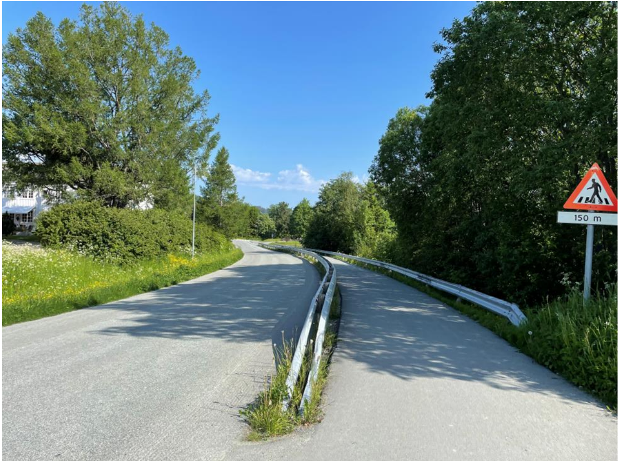
Figur 4.8 Gimsvegen sett mot nord. (Foto: NIRAS).
